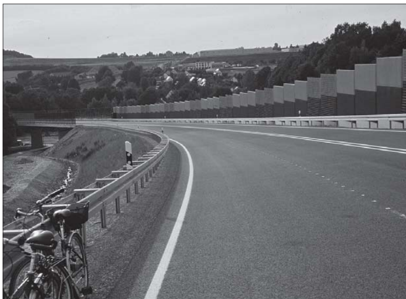
Bereich der Trasse mit fehlender Barriere zum Fledermausschutz. Diese könnten zugleich als Lärmschutzwände dienen.
